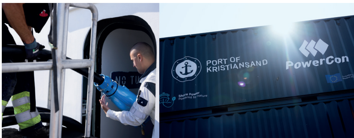
Kristiansand landstrømanlegg som leverer strøm til et cruiseskip.
